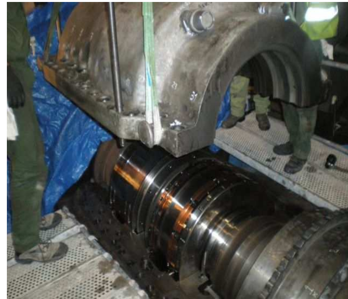
levantamiento carcasa cojinete
