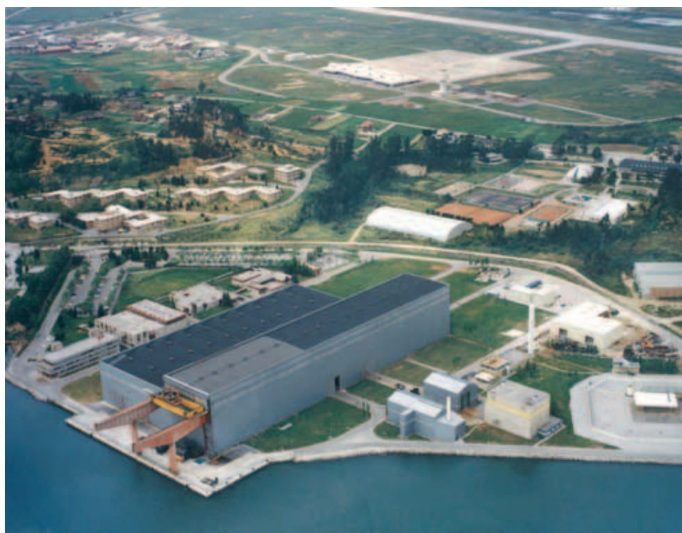
Vista aérea de las instalaciones de Equipos Nucleares, S.A., en la bahía de Santander.
